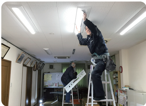
▲自治会館でのLED工事の様子
